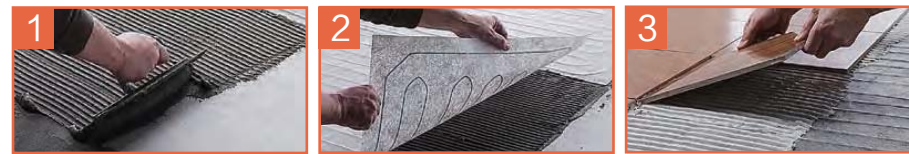
地面涂覆一层水泥/砂浆
