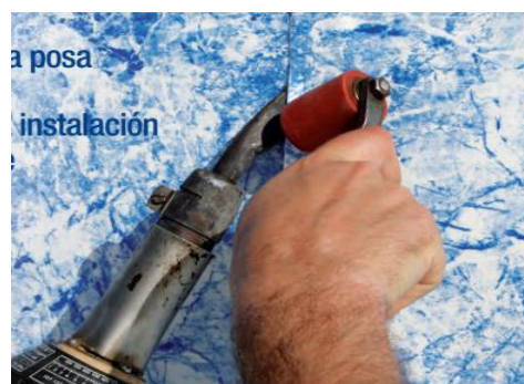
4. 池底、池壁焊接铺设
