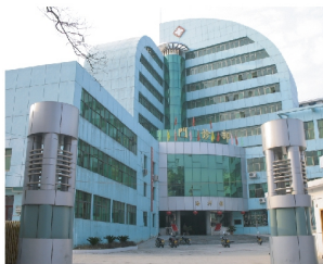
江西省赣州石城县人民医院
