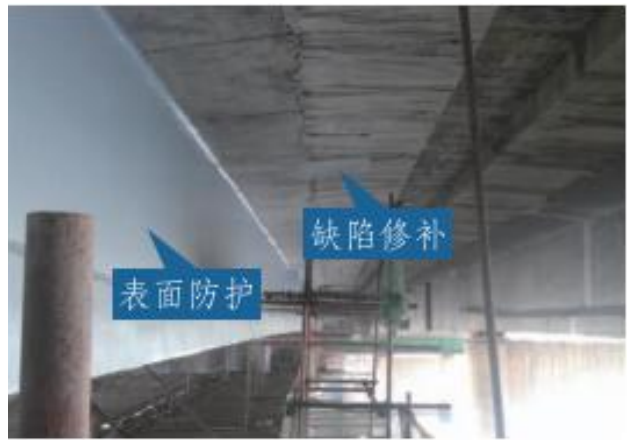
缺陷修补、表面防护
