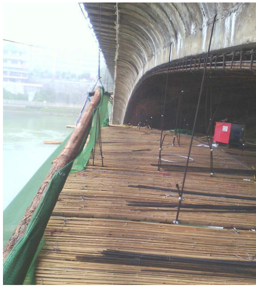
4、焦作瓮涧河桥 HPC 灌浆加固
